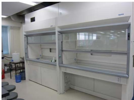
写真-1 室内における局所排気装置（左は湿式、右は乾式スクラバータイプ）
