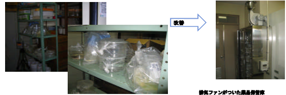
ビニールで保管された部材
