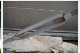
・ブレースの緩み（ターンバックルの変形）
