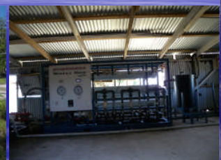
外国の援助で建設した淡水化装置
