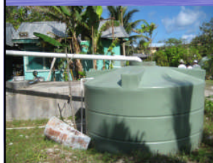
雨水をためる貯水タンク
