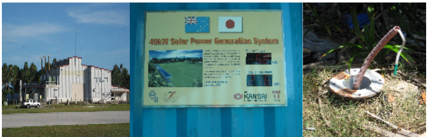
図6：ツバルの発電所と電気設備（左：ディーゼル発電所 中：太陽光発電システム 右：地中配線）
