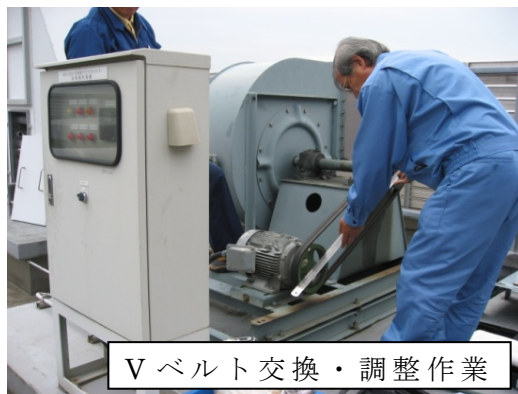
図 2. 排風機まわりの点検
