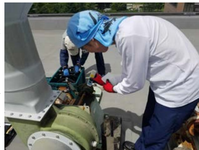
局所排気装置定期自主検査風景
