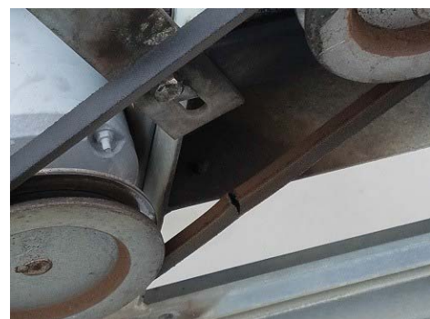
屋上排風機のVベルト破損
