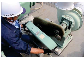
局所排気装置の点検
