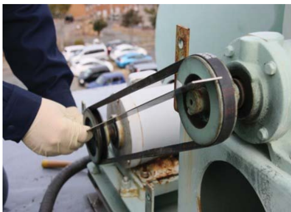
プーリーの調整(屋上)
