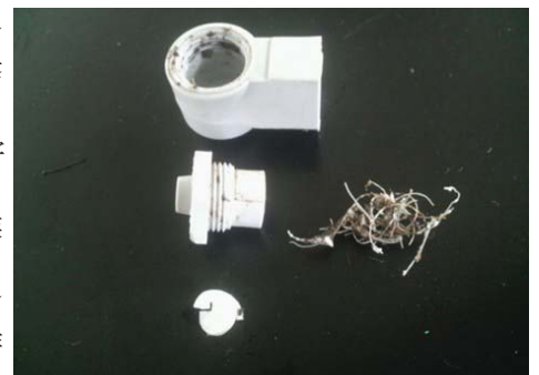
ノズルの詰まり(室内)
