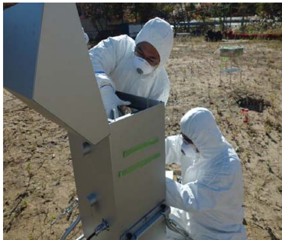
計測器設置作業
